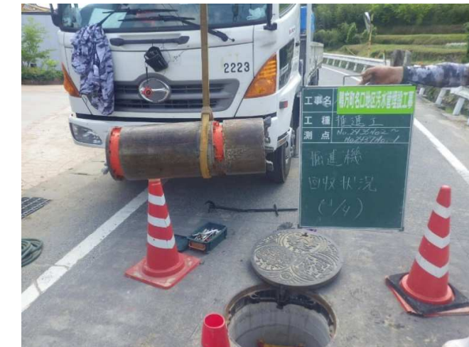
写真一 6 掘進機分割回収
