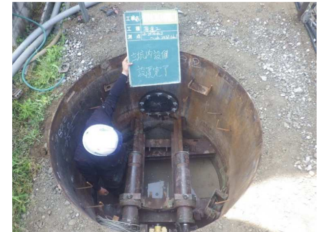
写真一 2 元押装置据付
