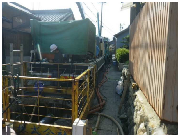
写真一 発進ヤード
