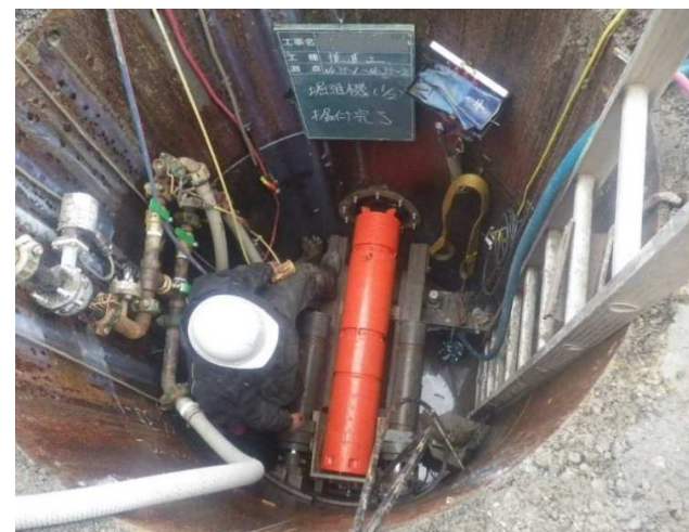
写真一 3 掘進機据付
