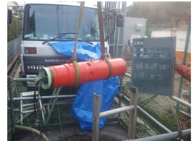
写真一 2 掘進機吊降し
