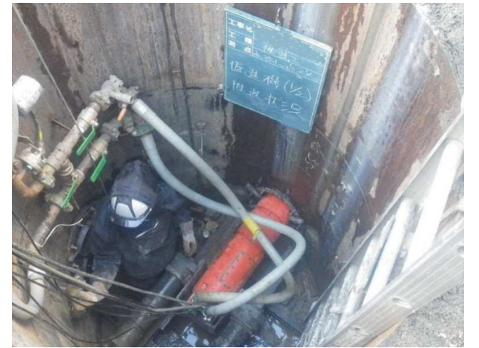
写真一 4 掘進機推進
