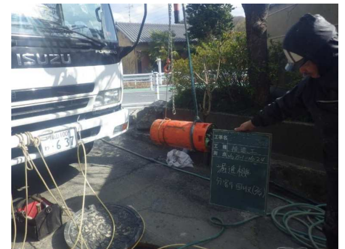
写真一 6 掘進機分割回収
