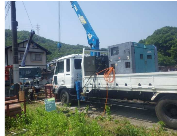
写真一 1 発進ヤード
