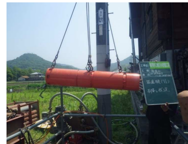
写真一 3 掘進機吊降し
