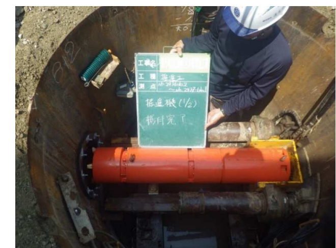
写真一 4 掘進機据付
