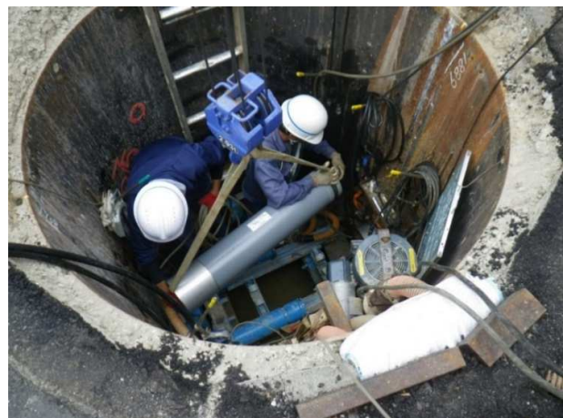
写真四 塩ビ管吊降し据付
