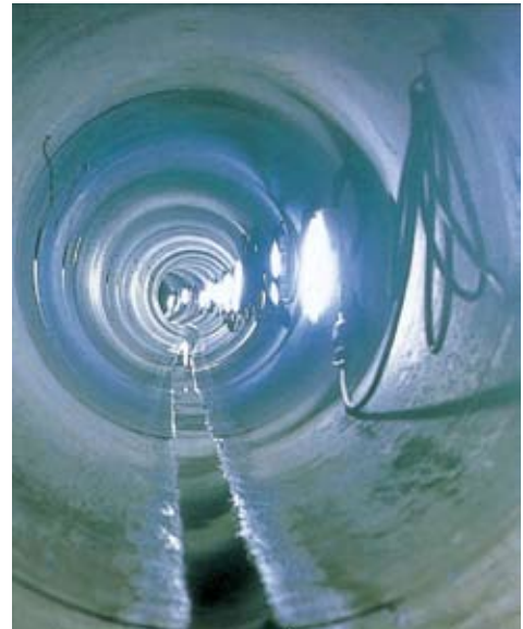
φ800 曲線100R管内状況
