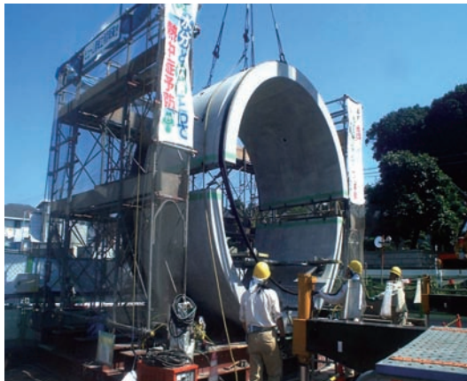
推進管組立状況
