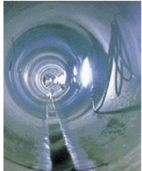
φ800 曲線100R管内状況
