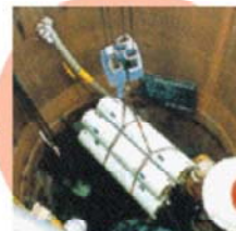
推力管の回収状況
