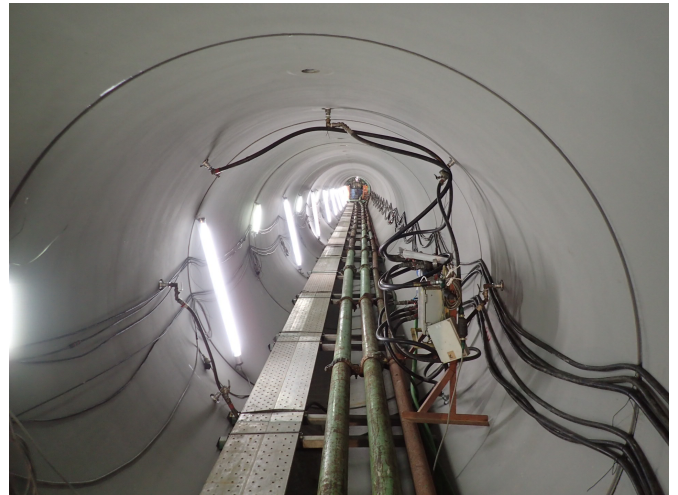
滑剤注入装置設置状況
