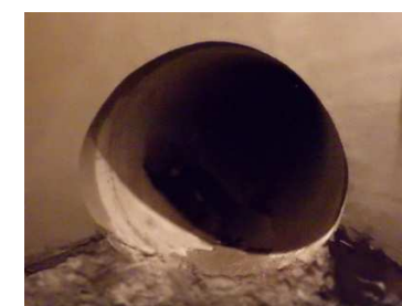
坑口仕上げ完了
