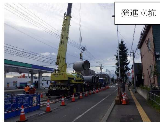
写真 - 2 発進立坑
